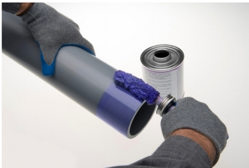
Apply primer to OD of pipe
